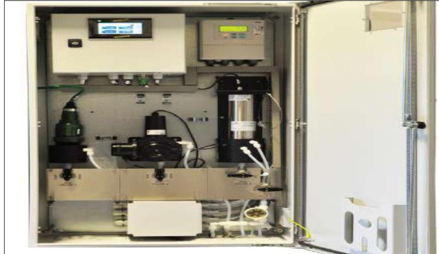
*Nota.* Componentes o sensores que conforman el sistema de monitoreo del agua de lavado (<https://greeninstruments.com>)
