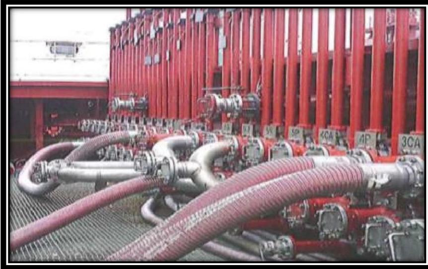
*Figura 1. Manifold de Carga.*
