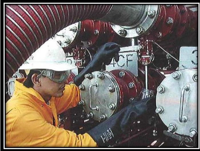
*Figura 6. Toma de Muestras desde el Manifold de Carga.*
