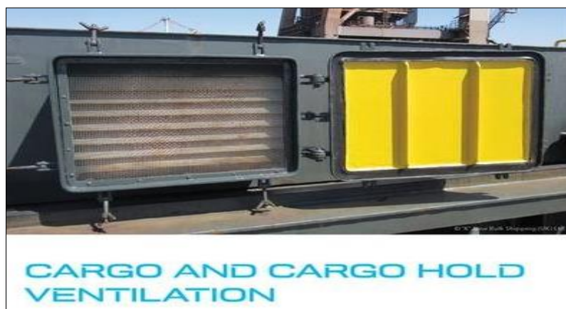
Figura 17. Ventilación de Bodegas.
