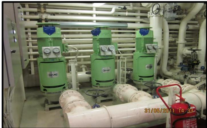
**Figura 8.** Bombas de transferencia (tanque de almacenamiento – tanque de sedimentación).
