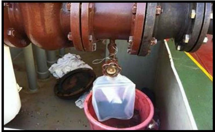
**Figura 6.** Brida de conexión con depósito para recolección de muestra.
