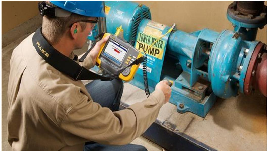
*Figura 14.* Mantenimiento preventivo de una bomba a bordo
