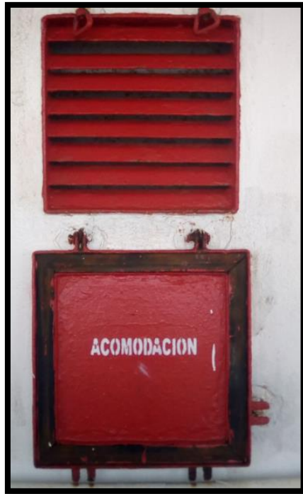
Figura 11: Cierre de ventilación.
