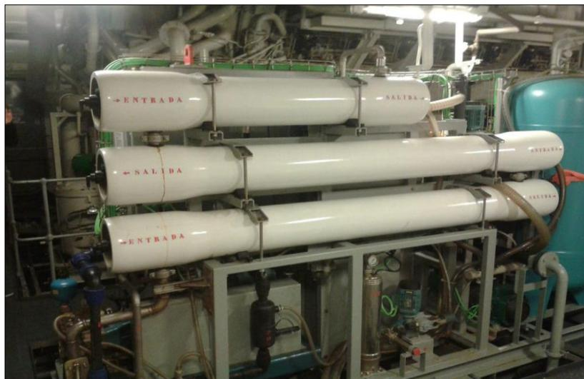
**El pre-tratamiento** es importante para evitar que las membranas lleguen a atascarse y perder efectividad de filtrado. Para ello se disponen de un ajustador del ph y una serie de filtros.
