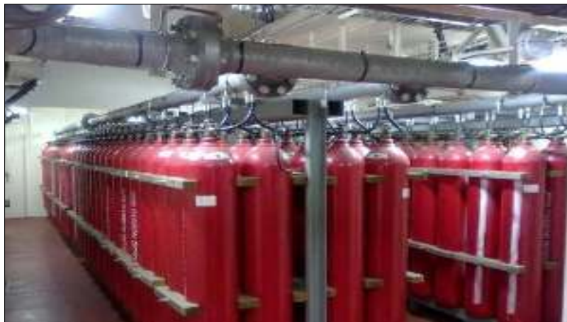
Figura 16. Sistema de dióxido de carbono en un buque.
