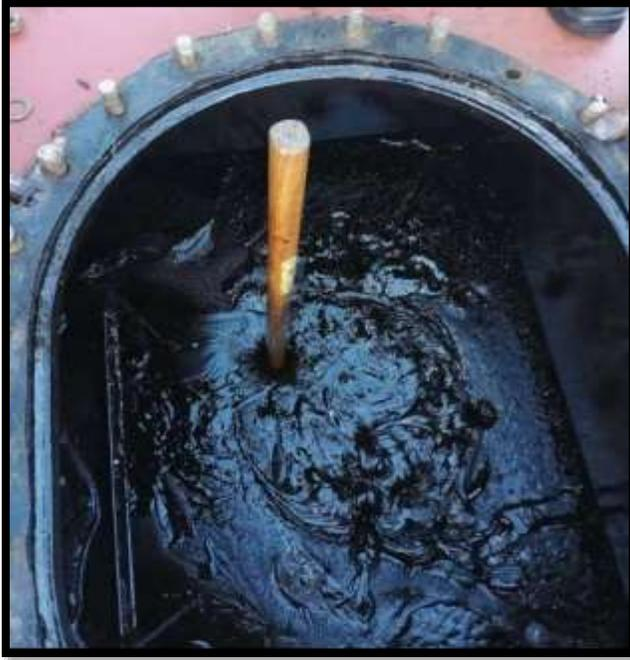
Figura 32. Fotografía de un tanque de almacenamiento cuyo combustible no recibió suficiente temperatura y se excedió el límite de su punto de fluidez.
