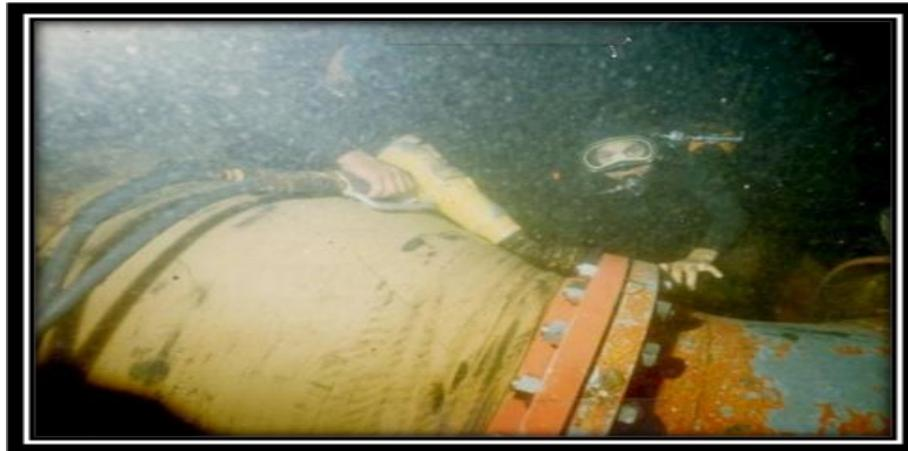
*Figura 57. Buzos instalando la manga de conexión*
