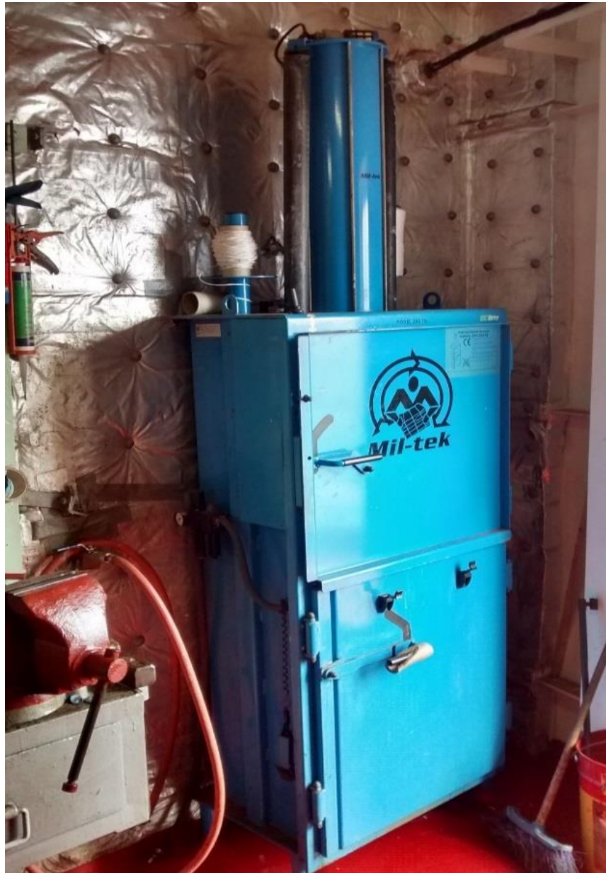
Figura 8: Compactador de basuras del M/T Montesperanza
