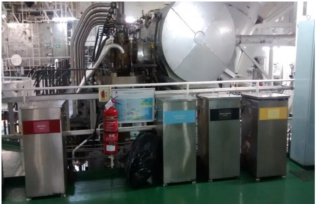
Figura 4: Contenedores de basura ubicados en el área de máquinas del M/T Montesperanza
