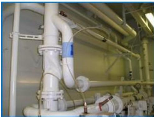
Figura 14. *Tuberías de distribución para agua potable.*
