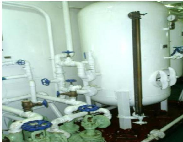
Figura 12. Modelo de hidróforo usado para dar fuerza a los tanques de agua.
