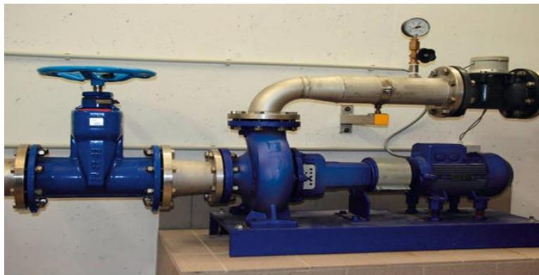
Figura 11. *Modelo básico de bomba de agua potable.*
