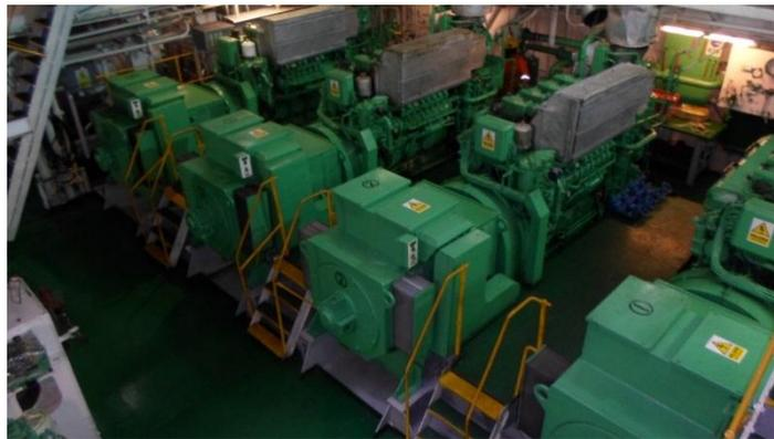
*Figura 9: Generadores de emergencia del Buque tanque “Paracas”*
