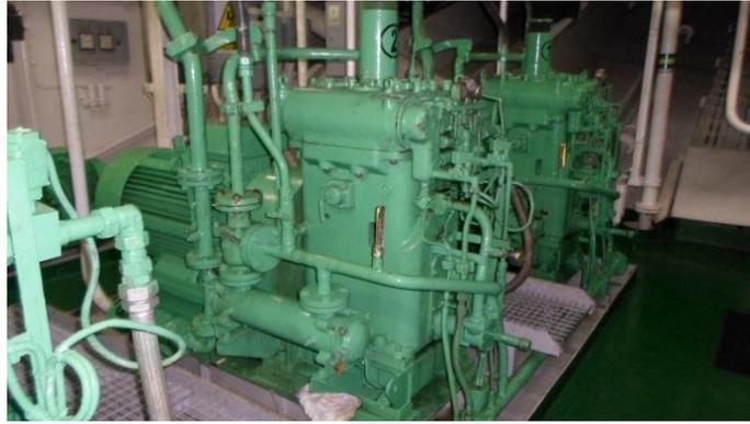
*Figura 10: Compresores de aire principal*
