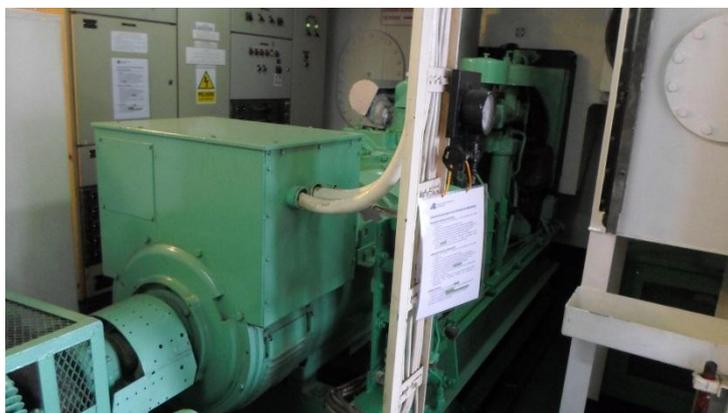
*Figura 5: Generador de emergencia*
