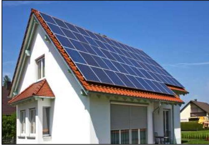
Figura 29. Montaje directo con cubierta inclinada
