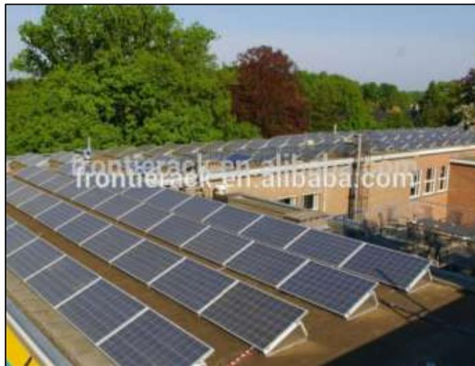
Figura 30. Montaje directo con cubierta plana
