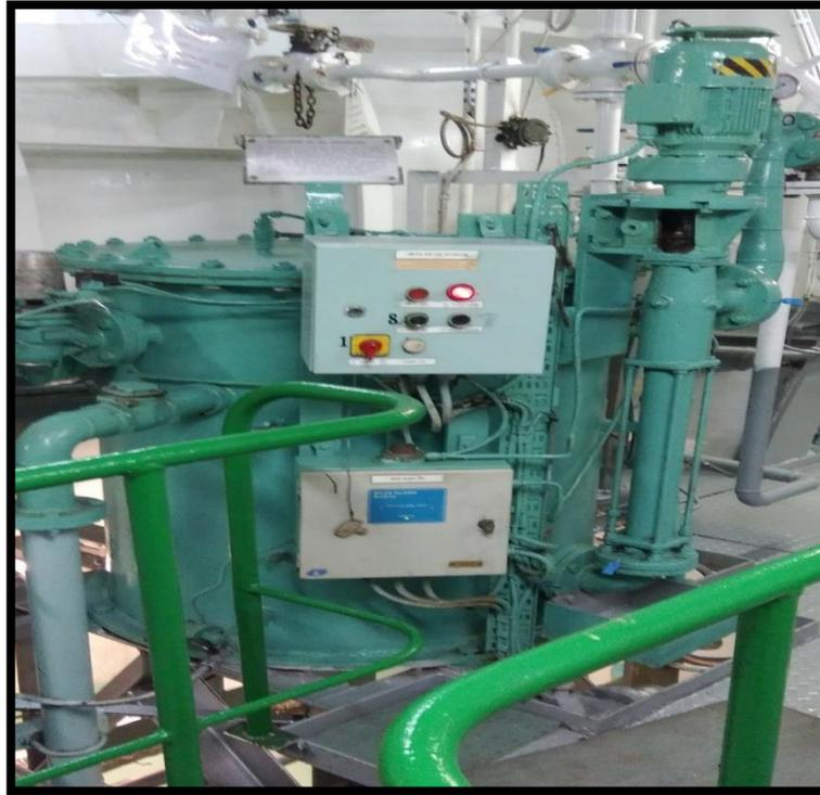
Figura 54: Separador de aguas oleosas B/T Nasca.
