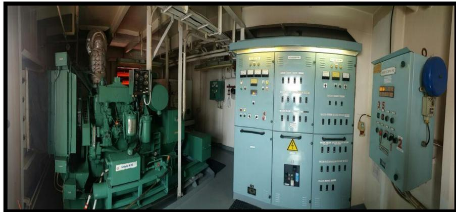
Figura 57: Motor Generador de Emergencia B/T Nasca.
