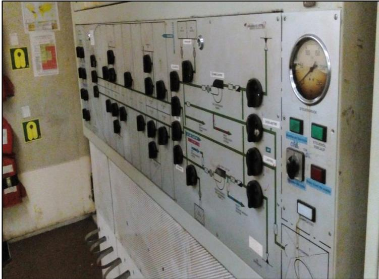
*Figura 40.* Tablero de válvulas de hidráulicas
