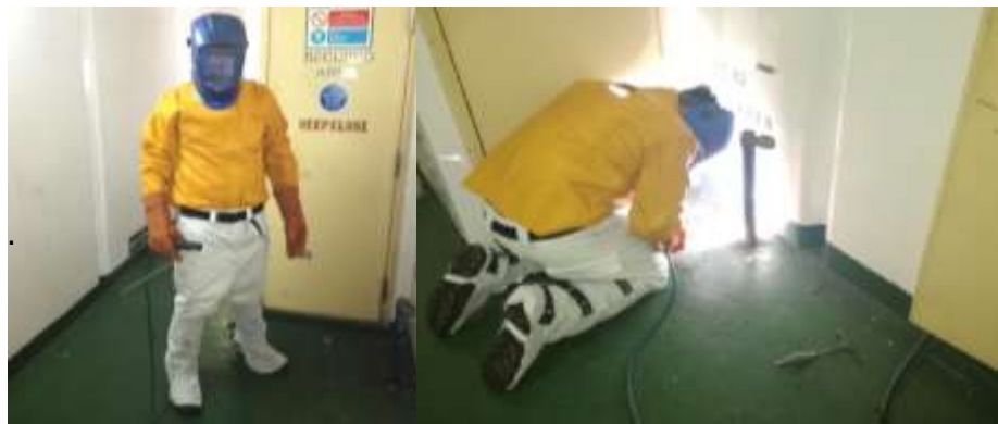
Figura 19. EPP de soldadura. Fuente: Elaboración propia.
